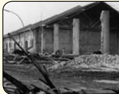
Die Negerhalle von innen - beim Abriss 1989
